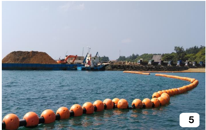
③塩川港で台船へ積み沖で輸送船に積み替え④大浦湾に到着した輸送船⑤K9護岸で赤土を台船からダンプに積み埋立現場へ
