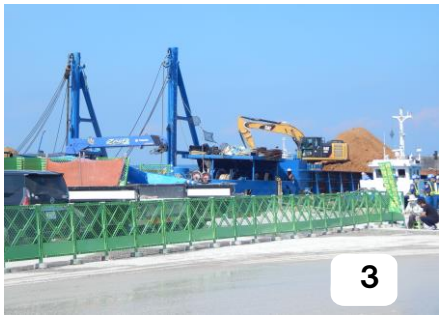
③塩川港で台船へ積み沖で輸送船に積み替え④大浦湾に到着した輸送船⑤K9護岸で赤土を台船からダンプに積み埋立現場へ
