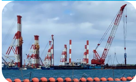
大浦湾内で砂杭を打つSCP船(左)とA護岸鋼管杭打設船(右)
